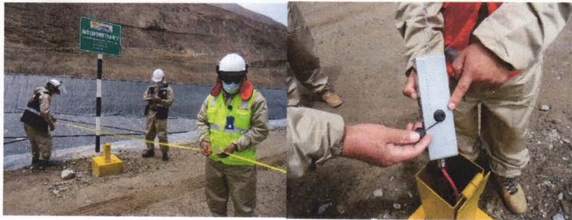
INSTALACIÓN DE INSTRUMENTACIÓN DE GEOTECNIA
